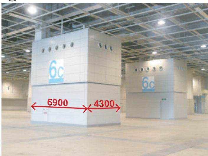
④ 非常階段 Emergency staircase
