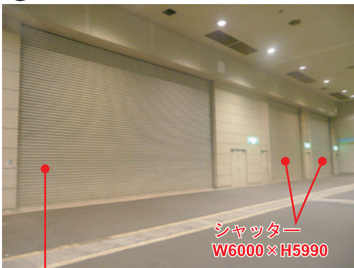
④ 搬入口 Delivery entrance
